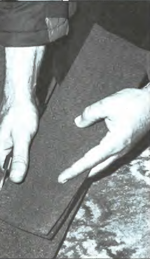
Afb. 4. Het dakleer wordt in stukken van de juiste maat gesneden of geknipt.
